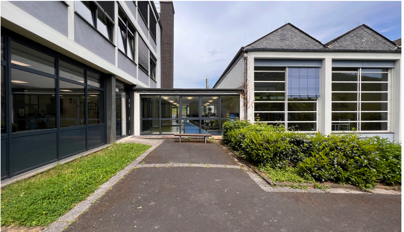
1.4 Blick auf alten Verbindungsbau / alte Sporthalle
