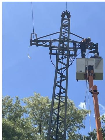
Die Leitungsseile wurden mithilfe einer Seilwinde auf die Strommasten an den Ufern gezogen. (Foto: Westnetz GmbH, Tom Fuchs)
