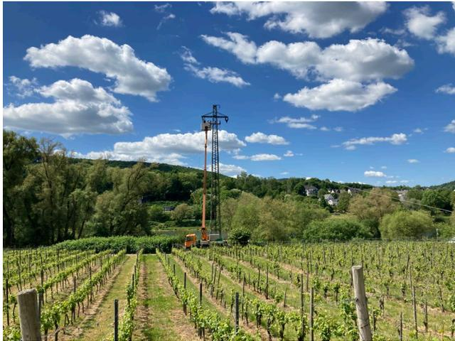
Drei Steiger kamen parallel zum Abspannen und Einregulieren der Leitungseile zum Einsatz.
