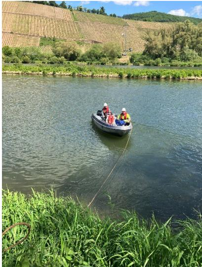
Mit einem Boot wurde ein Windenseil über die Mosel gelegt. Das Windenseil ermöglichte es, die Stromleitungen über den Fluss nachzuziehen. (Foto: Westnetz GmbH, Tom Fuchs)
